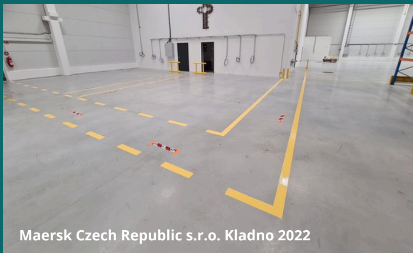
provedení dopravního značení v délce 440 bm za 8 hodin
