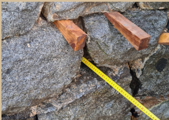
Hlinsko 2021 - spárování kamenných nábřežních stěn (řeka Chrudimka)
