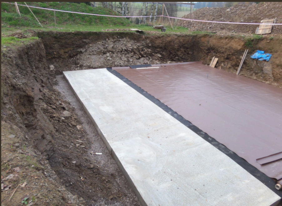
Zemní izolace rodinný dům Horní Bradlo 2014
