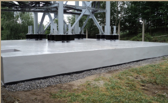
Sanace betonové patky vysílače Rudný 2015
