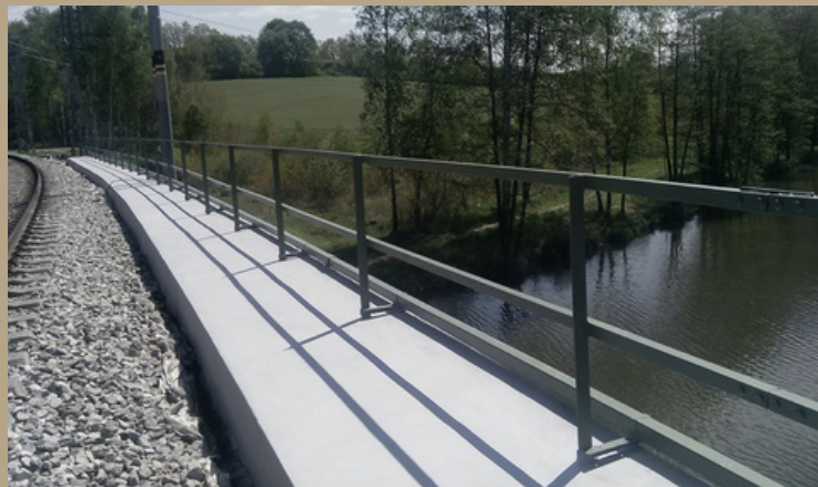
Sanace železničního mostu Havlíčkův Brod 2016
