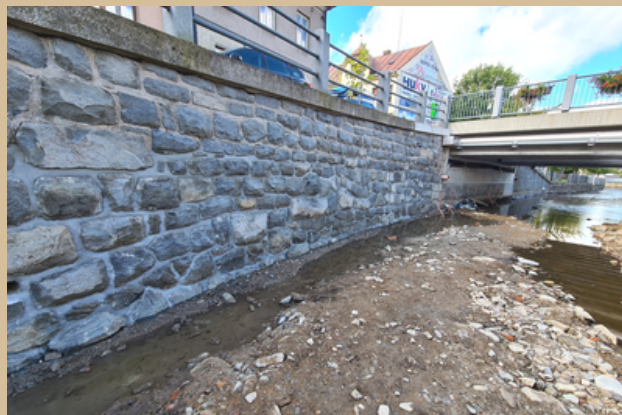
Hlinsko 2021 - spárování kamenných nábřežních stěn (řeka Chrudimka)
